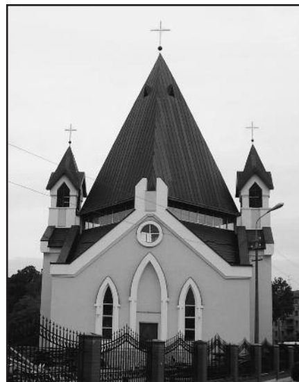
Строительство нового храма Пресвятой Троицы в Пскове, начатое в 2000 году, близко к завершению
